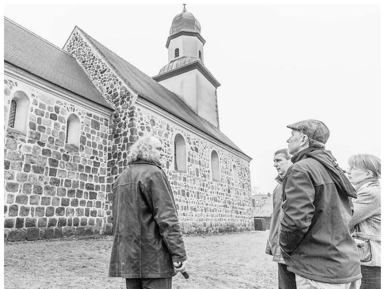
Stolz auf das gemeinsame Werk: Architekt Mike Enzmann, Pfarrer Matthias Stephan, Dachdecker Christian Kube und die Gruboer Kirchenälteste Katja Borchhardt (v. l.) begutachten das neue Kirchendach. FOTO: S. SPECHT
